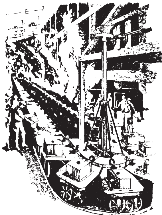
চিত্র ৬.১০ : শিল্প উৎপাদন-এতে একজন কর্মী একই সরল কাজের পুনরাবৃত্তি করে। এই নকশাটিতে জনৈক কর্মী সারিবদ্ধ টেবিলগুলির উপরে ব্লকগুলি বসিয়ে এবং চাকার উপরে স্থাপিত টেবিলগুলি লাইনপাতা পথে কারখানার ছাঁচে-ফেলা, ঢালাই-করা ও অন্যান্য কাজের ঘরগুলি দিয়ে যাচ্ছে।
